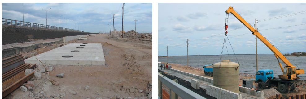
Рис. 2.13. Комплектные ЛОС на КЗС.
