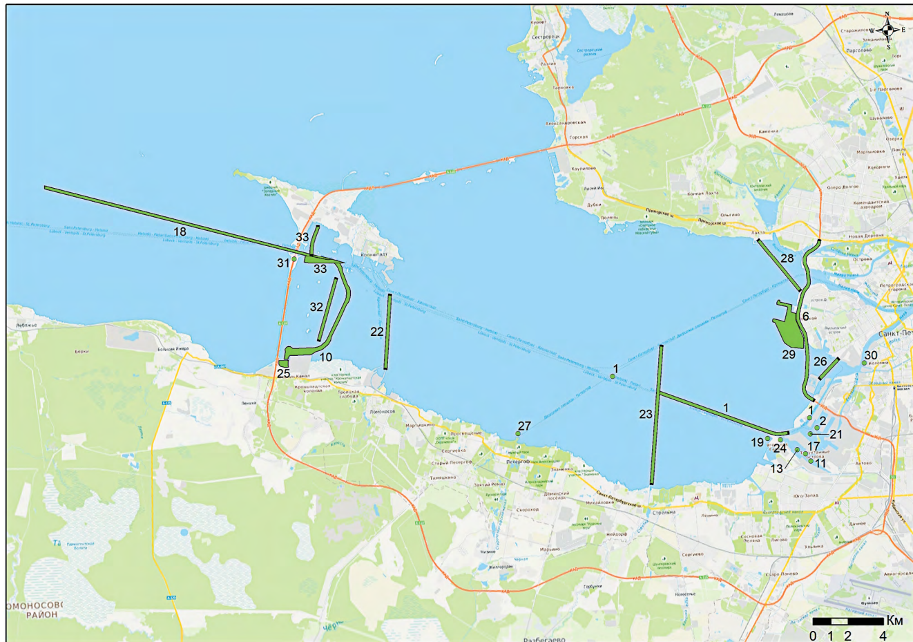
Рис. 2.4. Гидротехнические работы на акватории ВЧФЗ и Невской губы в период 2010–2014 гг. (нумерация объектов здесь и на рис. 2.3, 2.5 соответствует перечню ГТР в табл. 2.1).
